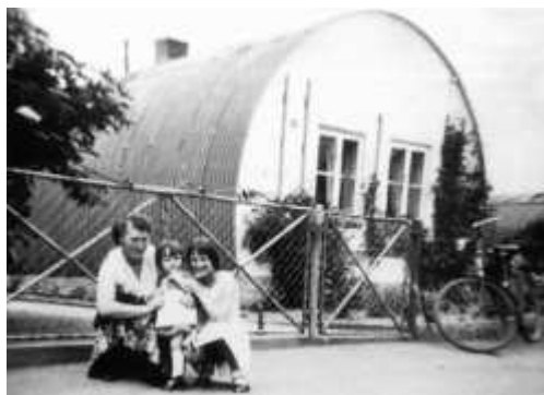
Nissenhütte in Bredstedt 1955. Die in Kanada erfundenen Baracken aus gebogenem Wellblech kamen mit den Alliierten nach dem Zweiten Weltkrieg nach Deutschland. Obwohl in Schleswig-Holstein nicht viele Nissenhütten aufgebaut wurden, sind sie zu einem Symbol der Notzeit nach dem Krieg geworden.
